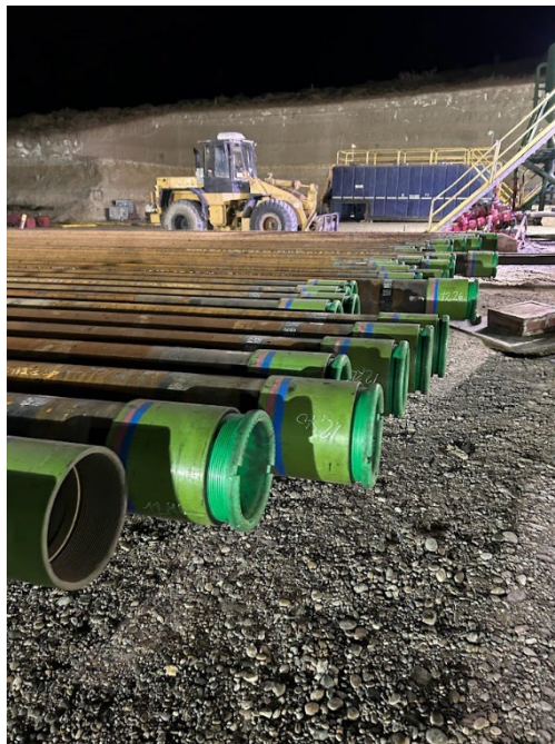
Tubería apostada en bancal
