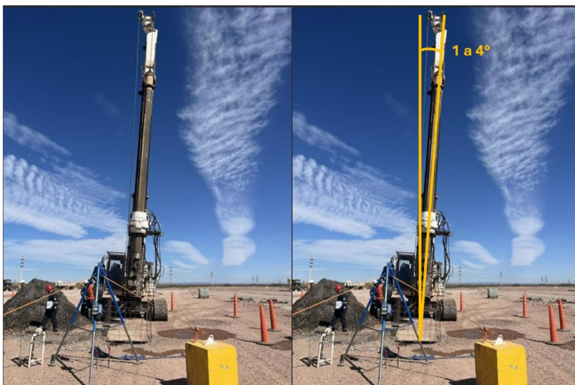
Imagen 17. Desvío con torre maquina pilotera con placa niveladora.
