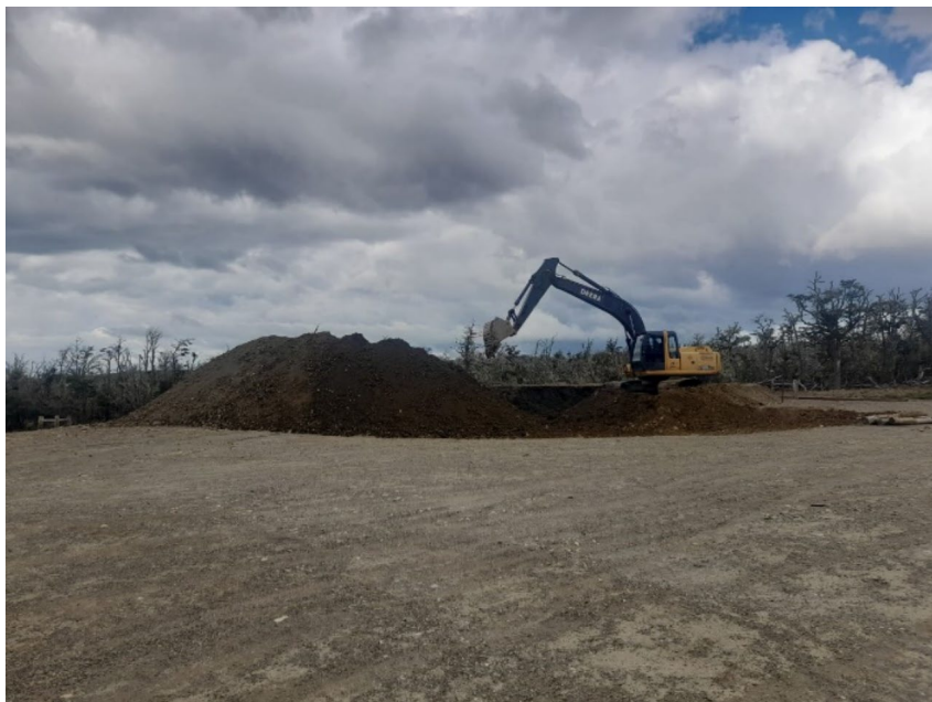
Figura 9: Retroexcavadora removiendo el cutting dentro de la playa de secado
