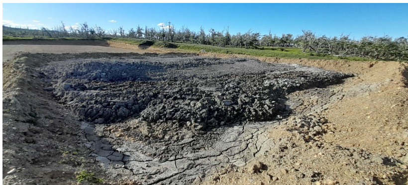
Figura 8: Imagen cercana de playa de secado pozo #2 después de la perforación
