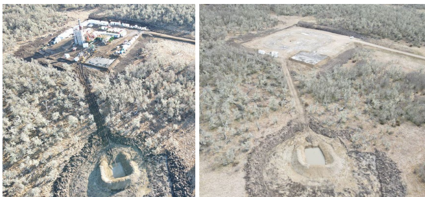
Figura 6: Locación del pozo #1 durante y después de la perforación
