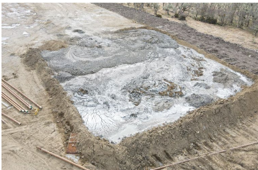
Figura 7: Imagen cercana de playa de secado pozo #1 después de la perforación
