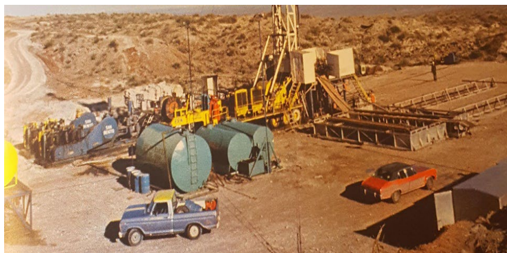
Imagen 3 Equipo de perforación convencional utilizado en los años 80 Fuente: San Antonio SA
