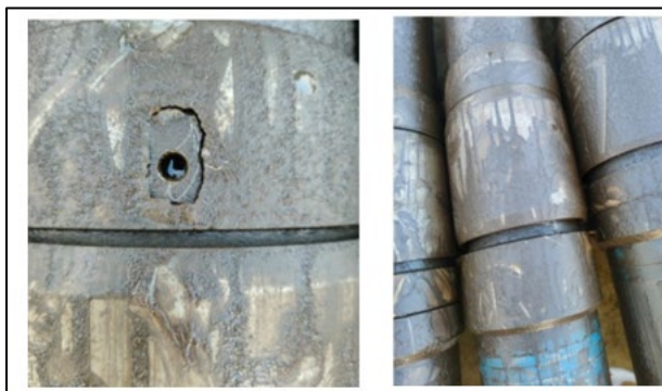
Figura 16. Desgaste de Camisas protectoras.
