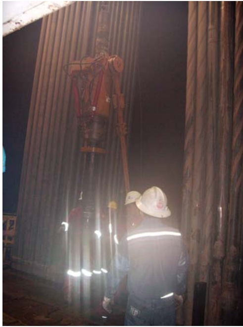
Fig. 2. Instalación del sistema Casing Drive
