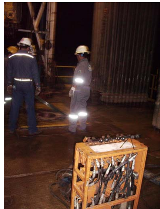
Fig. 5. Sistema hidráulico que proveen la potencia al sistema de acople
