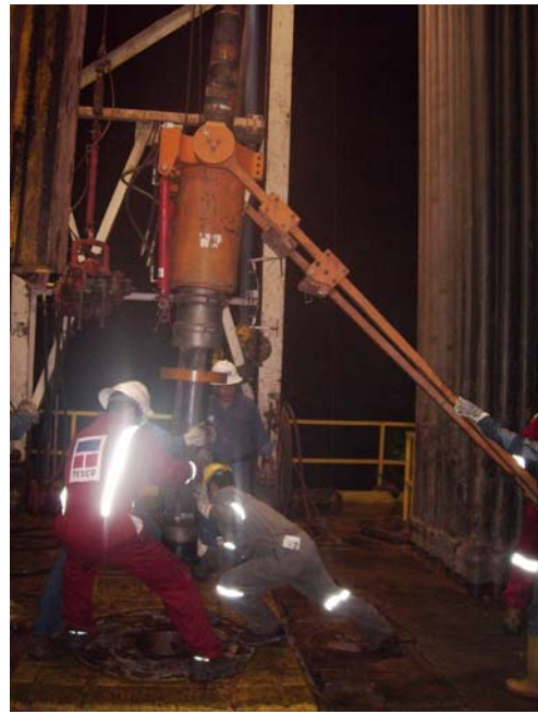
Fig. 3. Instalación del sistema de llenado automático del Casing Drive
