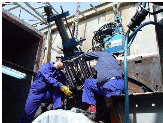
Taladro magnético zona Escape
