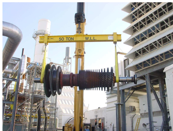
Desmontaje Rotor Turbina
