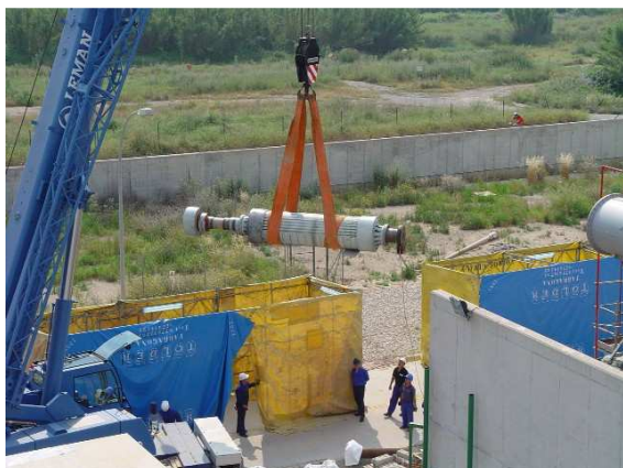
Zona Limpieza y Restauración Rotor Generador
