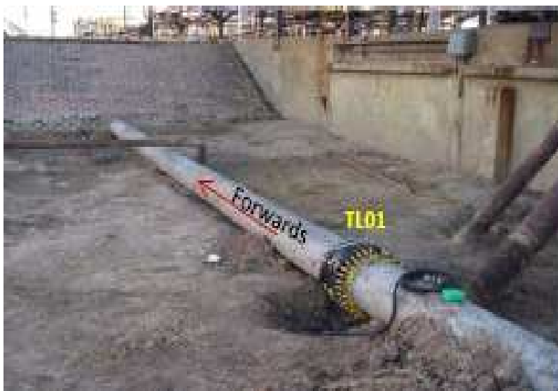
Figura 8: Ensayo realizado para inspeccionar un cruce de tajarar
