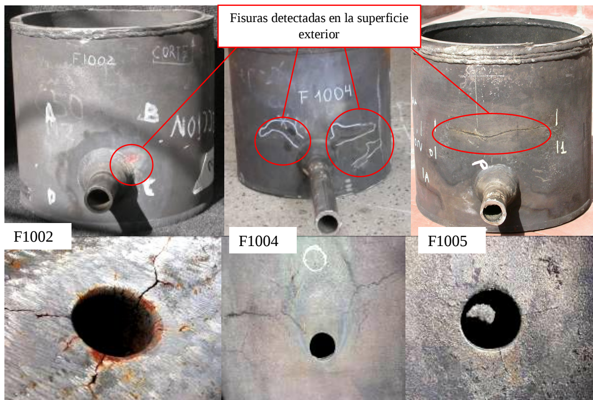
Fig. 2: fisuras en las zonas aledañas a los niples de medición de presión.
