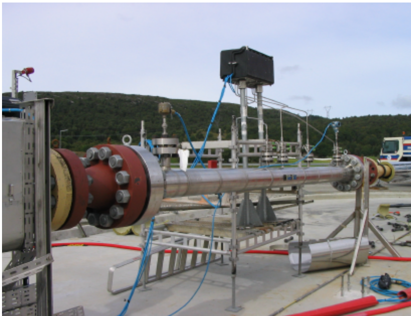
Medidor instalado en el laboratorio
