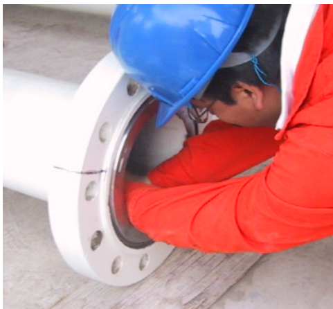
Foto 4. Medición Diámetro Interno Tubo de Medición
