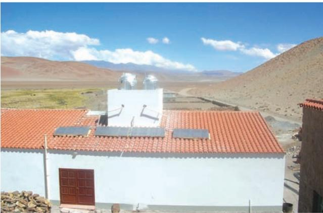
Figura 2. Sistema de calentamiento solar de agua instalado en la escuela albergue de la población Santa Rosa de los Pastos Grandes, Salta.
