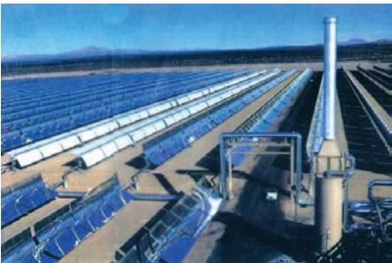
Figura 8. Sistema de generación eléctrica por vía solar térmica. Su potencia es de 300 megavatios. Los colectores cilindro-parabólicos lineales generan temperaturas superiores a los 300° C.
