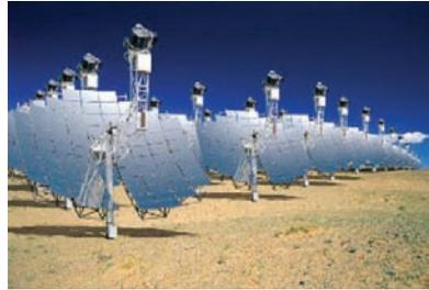
Figura 9. Versión artística de la planta de generación eléctrica por vía térmica a instalar en California. Consta de 20.000 concentradores con motores Stirling en cada foco.
