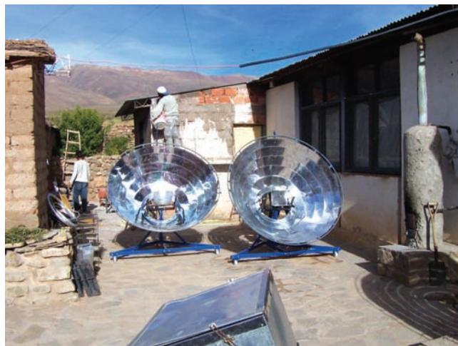
Figura 4. Cocina solar comunal con dos concentradores instalada en una escuela de la Puna a una altura superior a los 3000 msnm.
