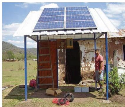
Figura 7. Instalación fotovoltaica destinada a alimentar un molino de granos en el área rural de Salta.
