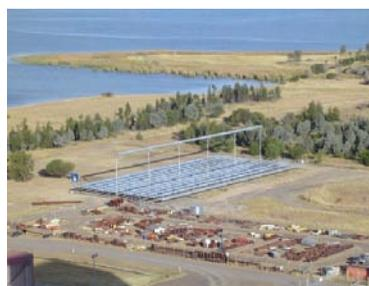
Figura 10. Planta prototipo de colectores solares de tipo Fresnel Lineal (LFC) instalada en Australia. Se aprecian los espejos lineales largos y en la altura el absorbidor que produce el vapor.
