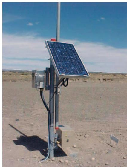
Controlador autoajustable con batería y panel solar 12V.
