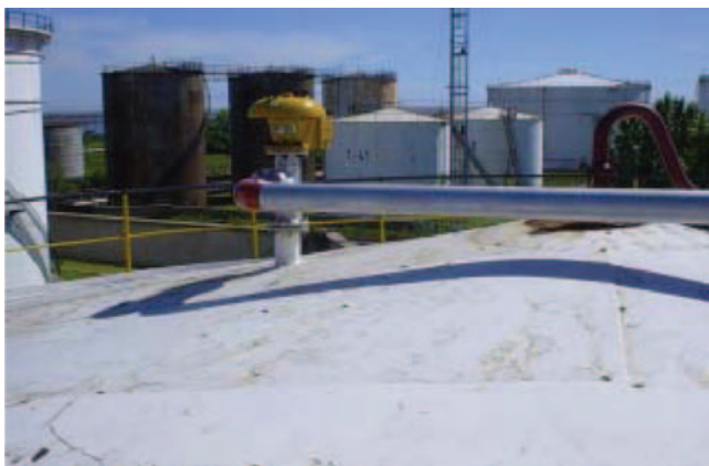
Línea de conexión de tanque al sistema de recuperación antes de la válvula de presión y vacío.
