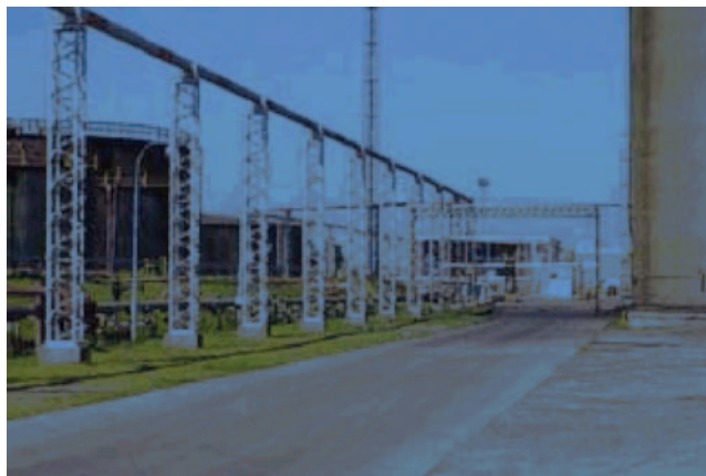
Vista líneas aéreas.
