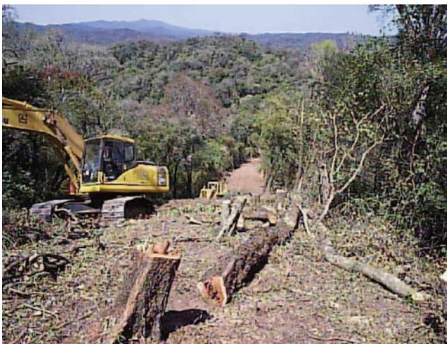
Foto 1. Apertura de gasoducto verde. La topadora entra después de las retroexcavadoras, la tala es selectiva.
