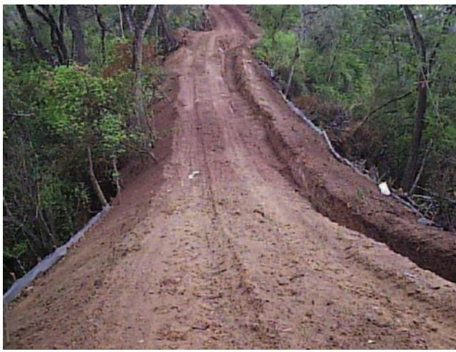
Foto 3. Retenciones longitudinales para lograr el ancho de pista necesario.
