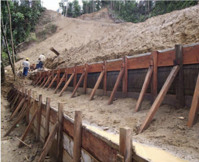
Foto 4. Retenciones artesanales para depósitos de suelo de corte.
