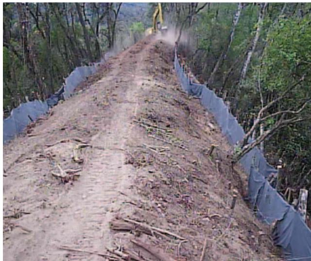
Foto 2. Retenciones antes de ser llenadas para lograr el ancho de pista.
