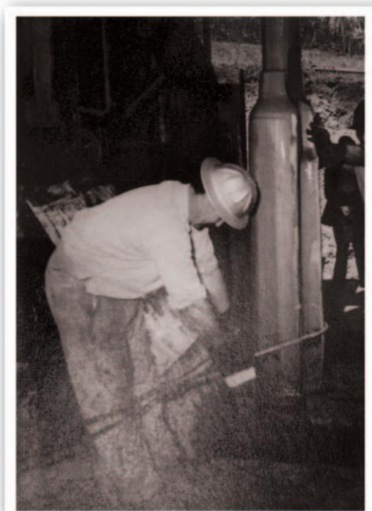
Acomodando, en boca de pozo, el trépano de perforación a cable.
