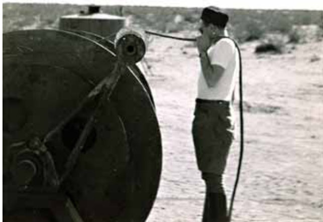
En la zona de Los Baguales (Yacimiento Plaza Huincul) con el equipo de Perfilaje Electrónico YPF N° 2.
