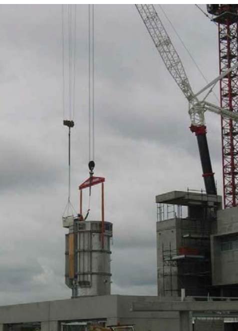
Colocación del tanque del reactor.
