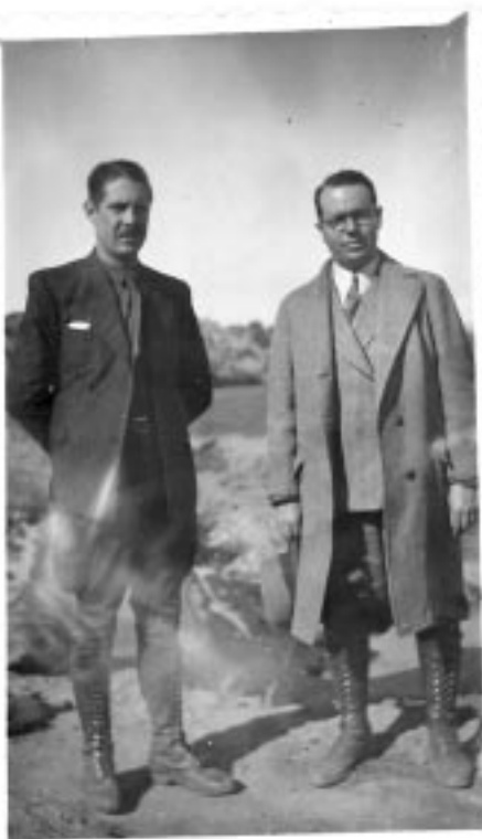
Lomazzi (izq.) con el Ing. Stock, Jefe de obras del Oleoducto Tupungato-Anchoris.
