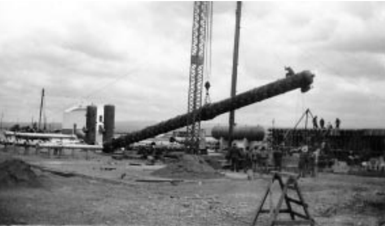
Montaje de una torre de 36 metros de alto en la construcción de la Destilería Luján de Cuyo.
