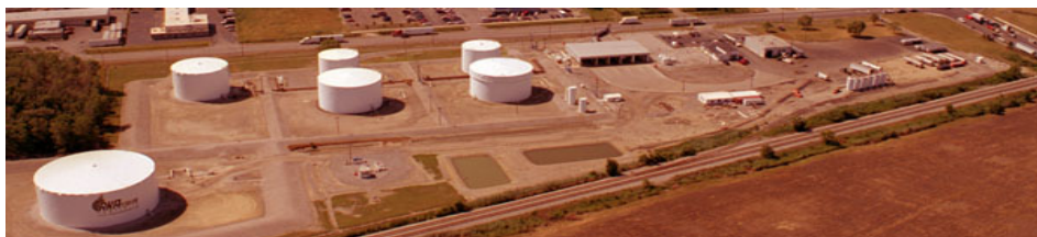
Figura 1. Visão aérea de um terminal
