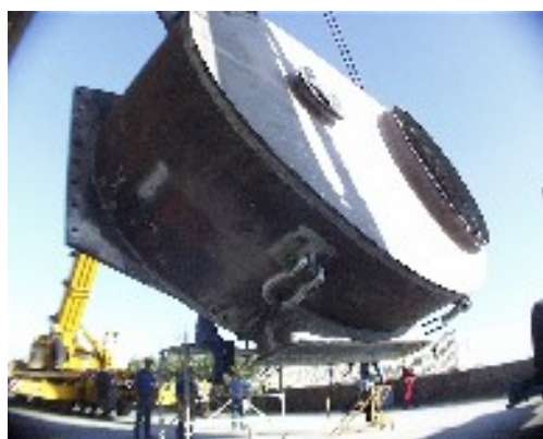
IV. Movimentação da carcaça durante montagem
