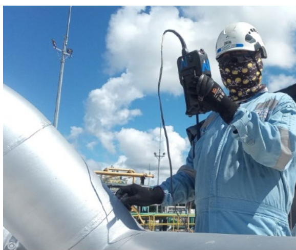
Imagen 1: Inspección mediante medición de espesores UTME.
