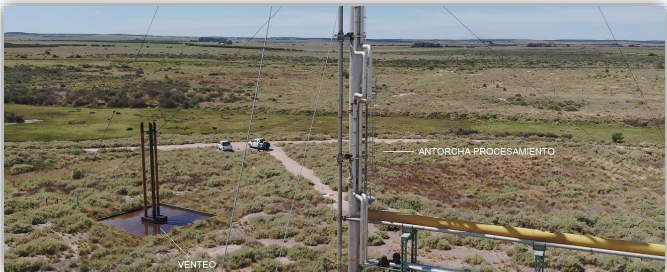
Figura n°3: Vista aérea del sector
