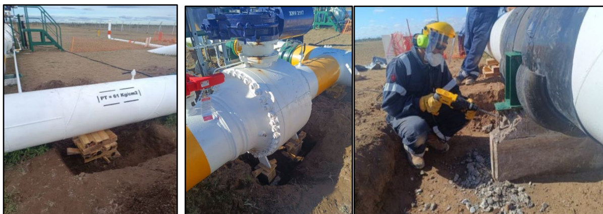
Figuras 16 a 18. Obra civil para armado de soportería provisoria.
