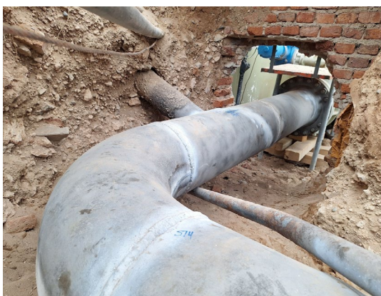
ILUSTRACIÓN 4 – DESTAPE CAÑERÍA
