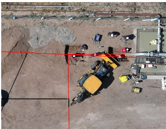
IMAGEN 7 - GEO DETECCIÓN ANTES DE COMENZAR A EXCAVAR
