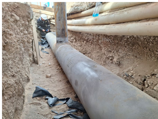
ILUSTRACIÓN 4 – DESTAPE CAÑERÍA
