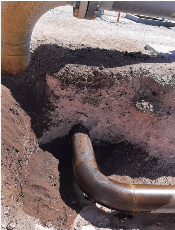
IMAGEN 14 – PERDIDA DE CONTENCIÓN Y COLOCACIÓN DE REPARACIÓN PROVISORIA
