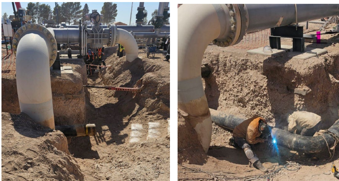
IMAGEN 15 – RETIRO DE REPARACIÓN PROVISORIA Y CAMBIO DE TRAMO
