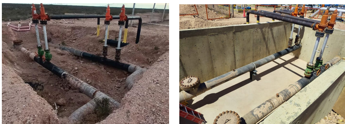
IMAGEN 16 – OBRAS CIVILES POST INTERVENCIÓN
