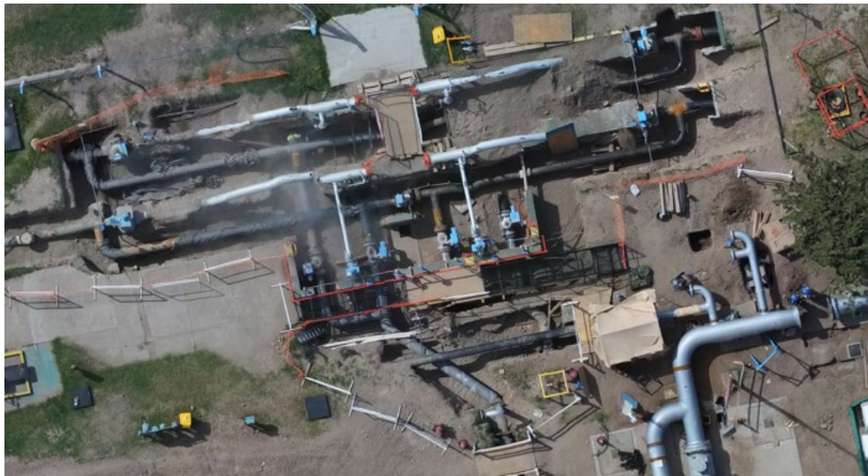
IMAGEN 1 – RAMAL CAÑERÍAS INGRESO A PLANTA
