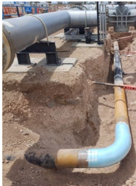
IMAGEN 14 – PERDIDA DE CONTENCIÓN Y COLOCACIÓN DE REPARACIÓN PROVISORIA
