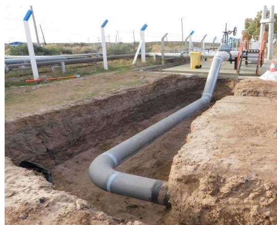
IMAGEN 8 – EXCAVACIÓN Y ACONDICIONAMIENTO SUPERFICIE
