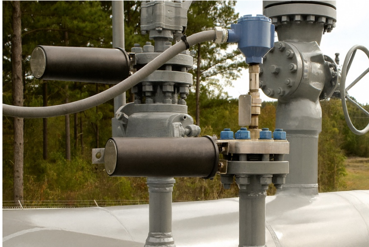
Figura 4. Desacoplador de estado sólido en conexión bridada.
