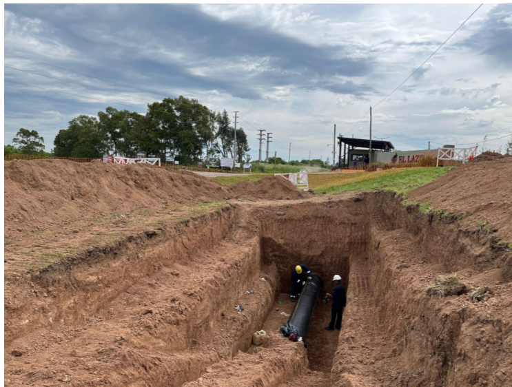
Fig. 9: Ducto expuesto mediante excavación controlada
