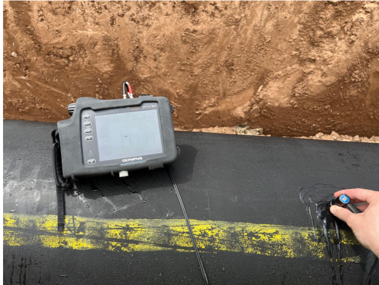
Fig. 10: Ensayo de adherencia y determinación de espesor en el material base mediante ultrasonido.
