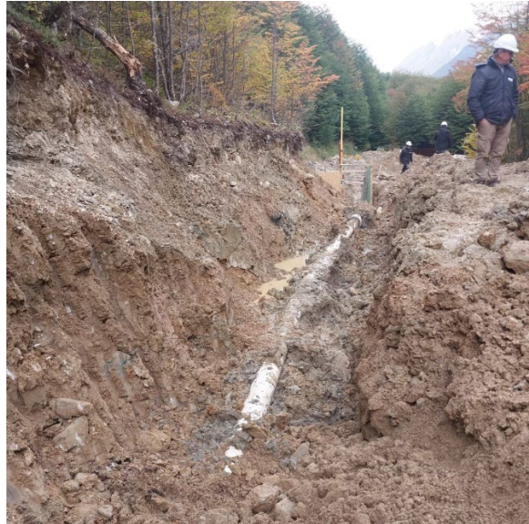
Fig. 1. Extracción del tramo: pendiente y ducto curvado.
