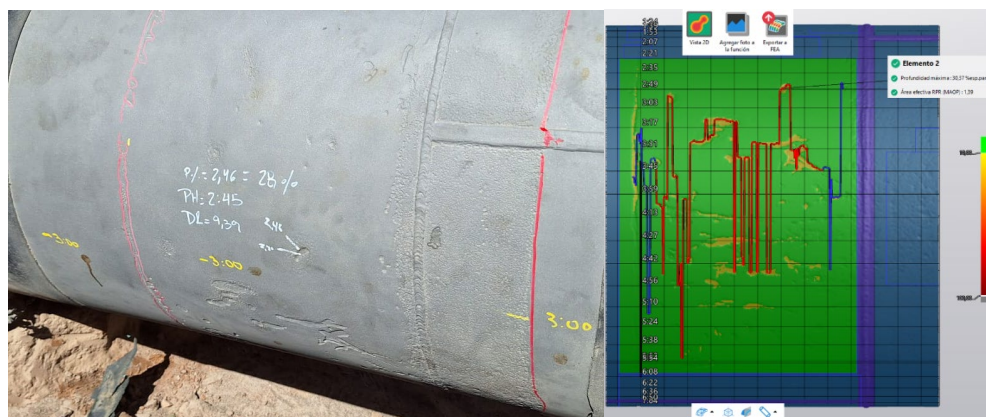
Figura 5 - Escaneo de defecto y armado de perfil
