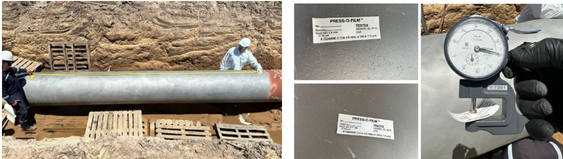
Imagen 3: ubicación de zona de reparación – limpieza superficial
