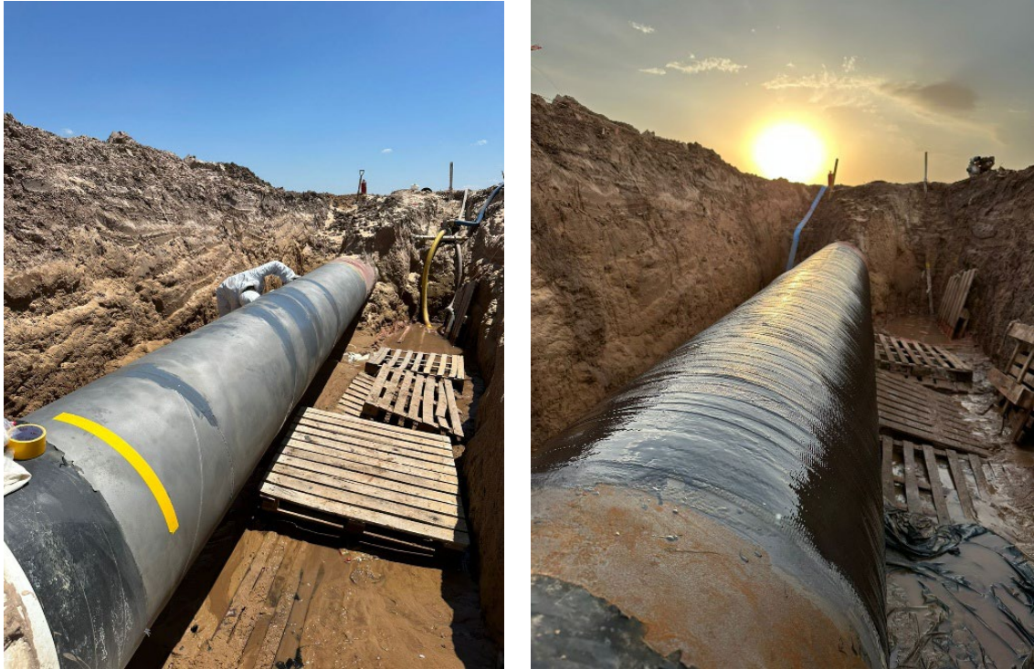
Imagen 5: proceso de colocación de filler y encintado
