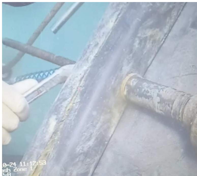
Fig. N° 23 – Foto submarina en primer plano de buzos apretando un perno largo para cerrar las bridas
