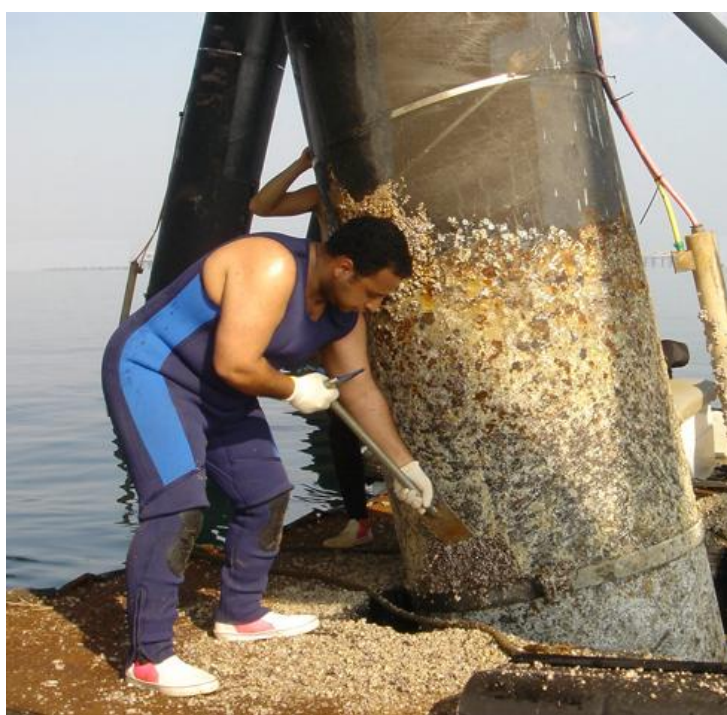
Fig. N° 12 – El raspado manual evita la utilización de un costoso, lento y contaminante sistema de arenado, granallado ó por chorro de agua
