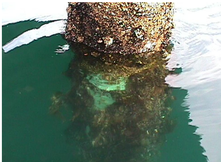
Fig. N° 7 – Fotografía tomada de una pulsera de epoxi grueso que se estaba cayendo en trozos. Efectivamente, se creó una celda de corrosión seria donde la corriente de PC no podía llegar debido al alto espesor del epoxi. Lo mejor, en este caso, sería retirarlo por completo.
