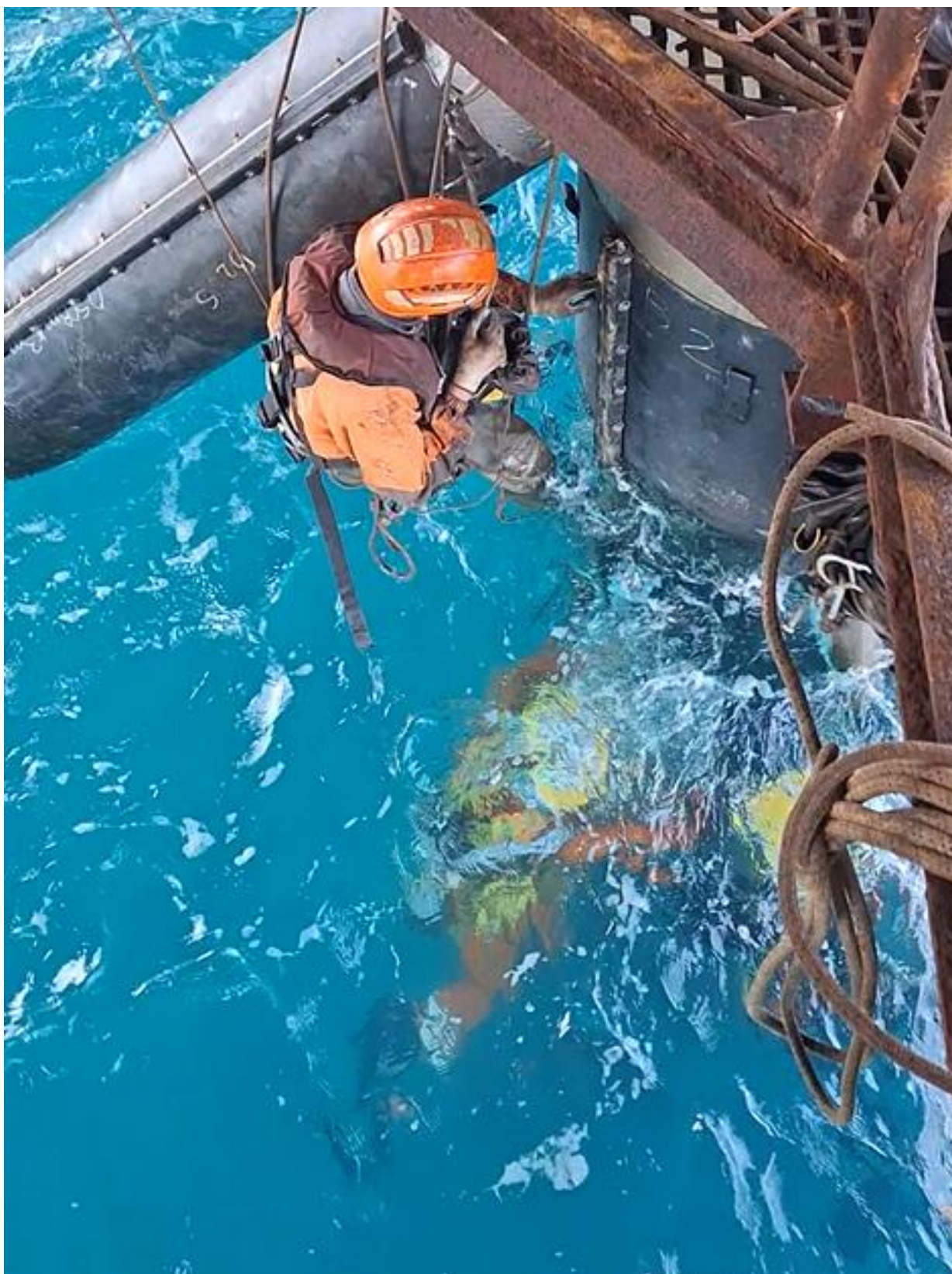
Fig. N° 21 – Pernos permanentes completamente instalados por encima del agua. Los buzos aún trabajando debajo del agua.
