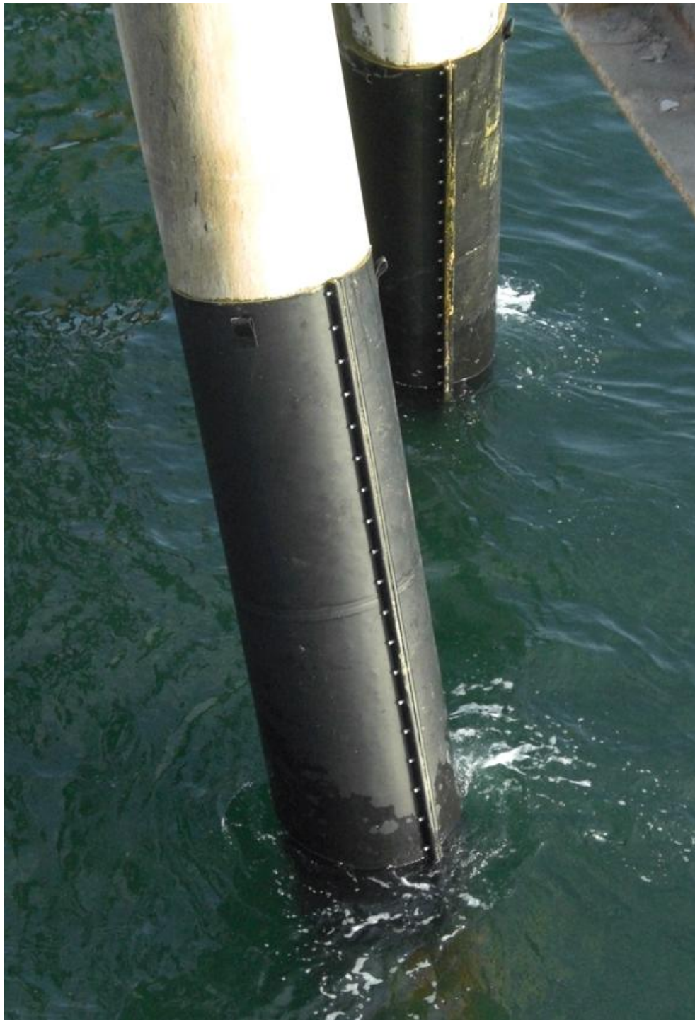
Fig. N° 9 – Chaqueta desmontable de una sola pieza con capa exterior reforzada y cierre atornillado
