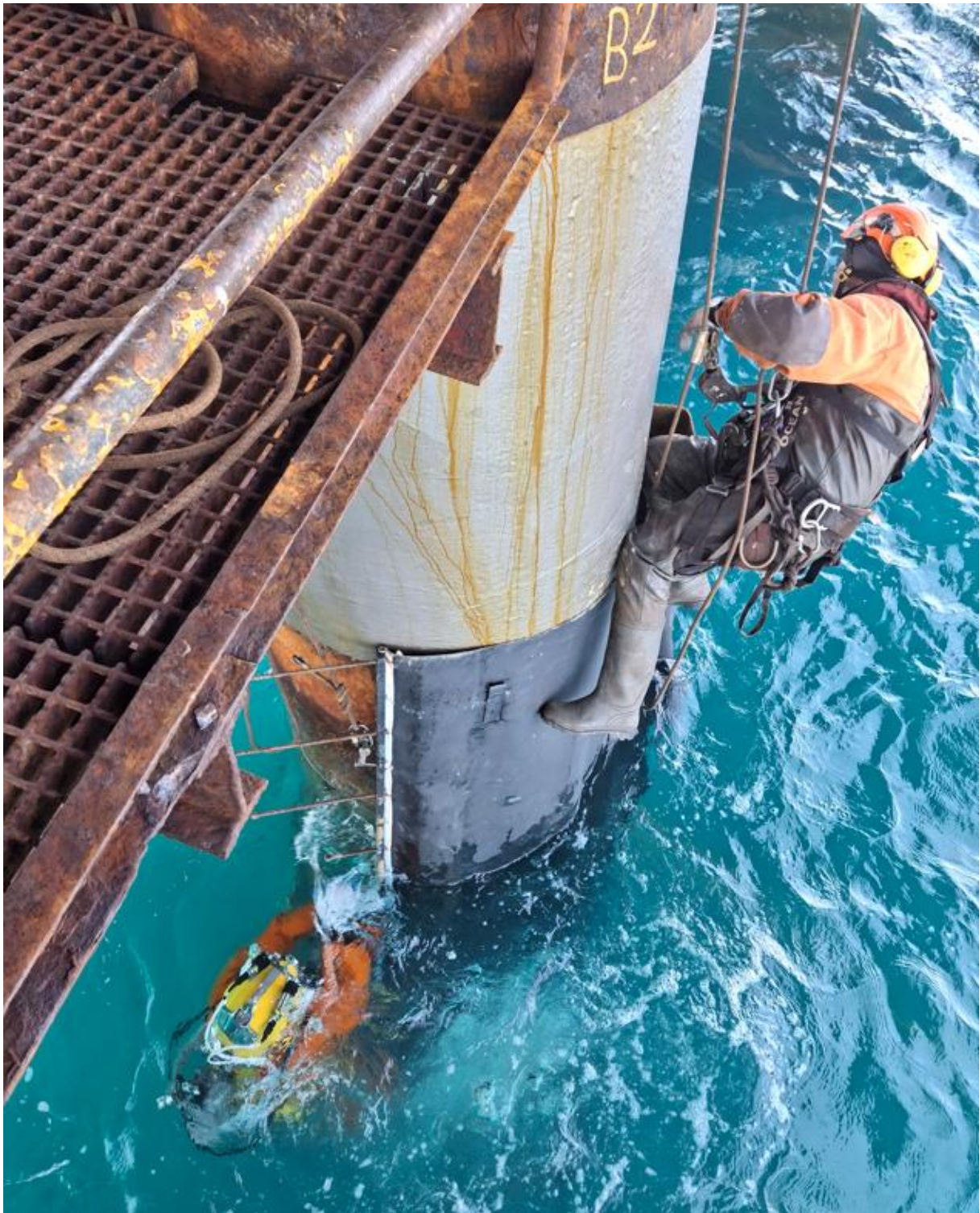
Fig. N° 18 – Buzo y técnico de acceso por cuerda posicionando la chaqueta antes de aplicar tensión
