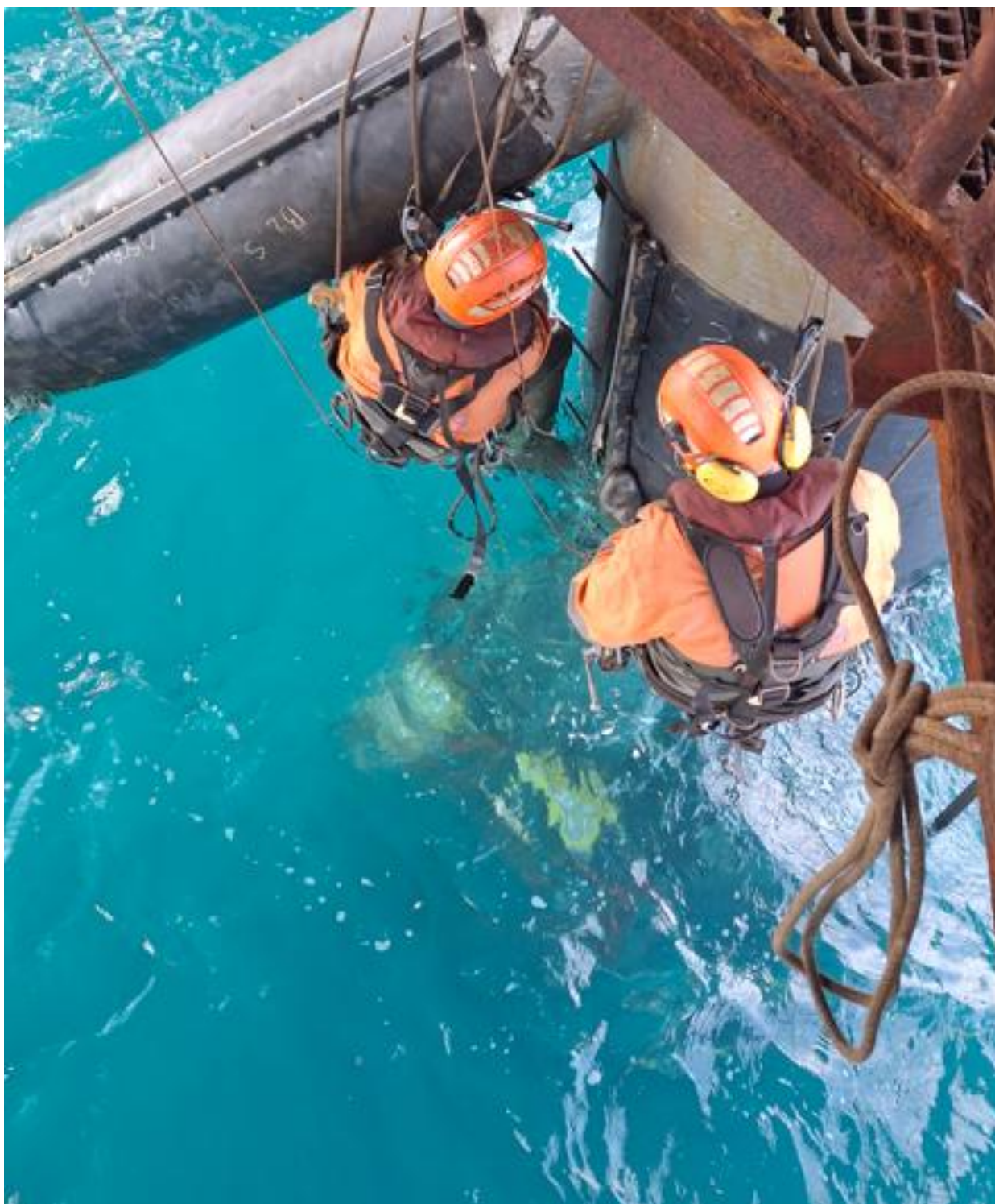
Fig. N° 20 – Chaqueta casi completamente cerrada, lista para la colocación de los tornillos permanentes de acero inoxidable
