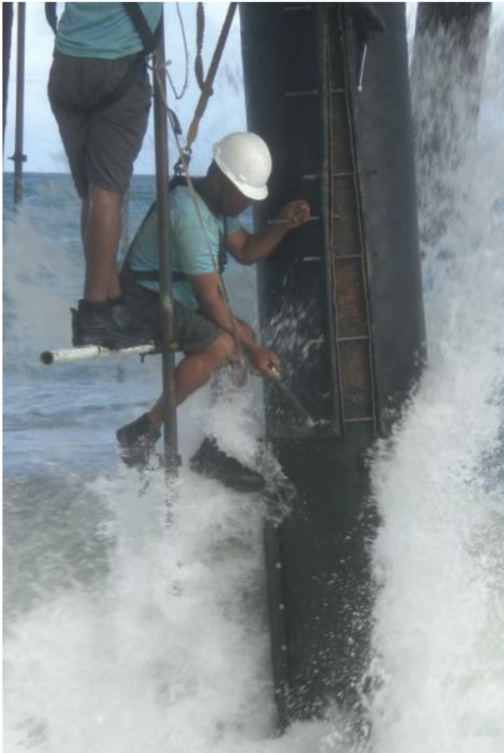
Fig. N° 15 – Frente a la acción de fuertes olas altas, se instalaron dos chaquetas en cada pilote de 22" de diámetro, comenzando desde el nivel de la playa hasta justo debajo de la superestructura de hormigón.
