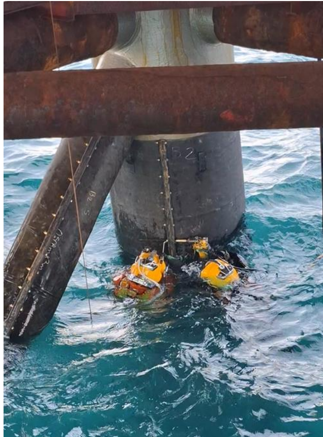
Fig. N° 22 – Buceadores terminando los últimos pernos en la zona de salpicaduras
