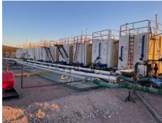
Figura 4. Montaje de piletas.
