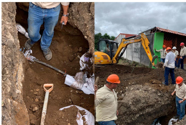
Figura 6: Un punto de extracción subterráneo descubierto en Costa Rica
