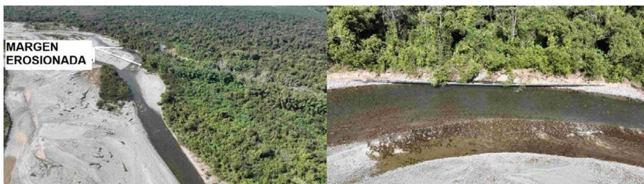
Figura 14. Caso 3 – Invasión del río hacia la pista – Río Blanco, Salta
