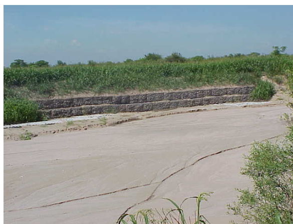
Figura 27. Protección de margen derecha construida sobre el Troncal junto con el cruce nuevo
