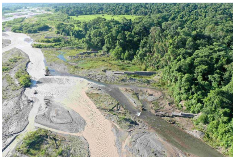
Figura 37. Vista hacia aguas debajo de la obra de protección de la margen derecha
