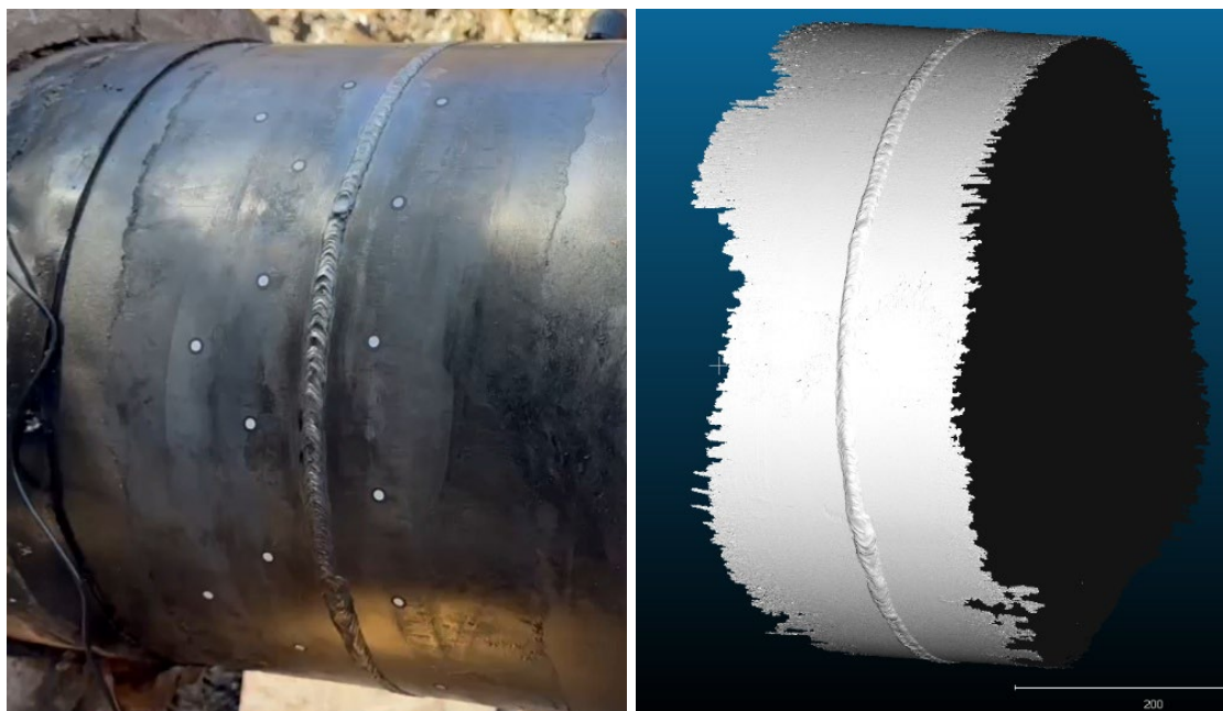
Figura 15. Zona de Inspección. Caso2.
