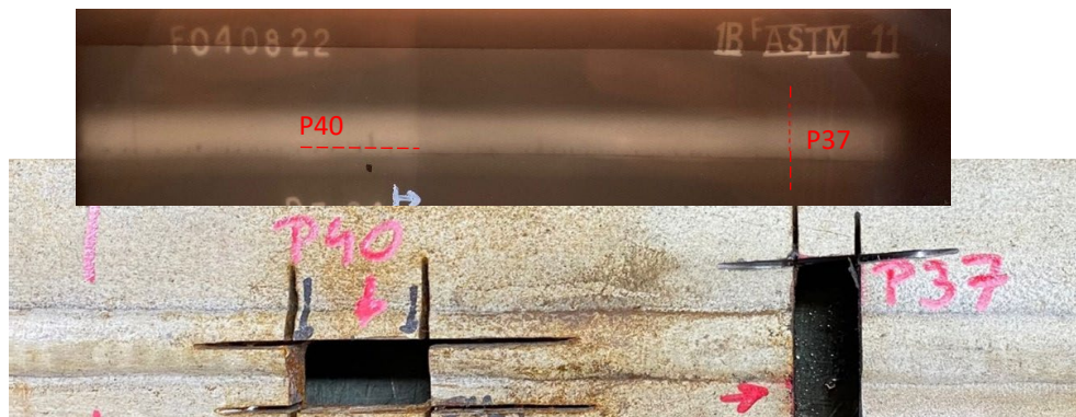
Fig. 15: Zona de extracción de las probetas P40 (Defecto B*) y P37 (Defecto D*).
